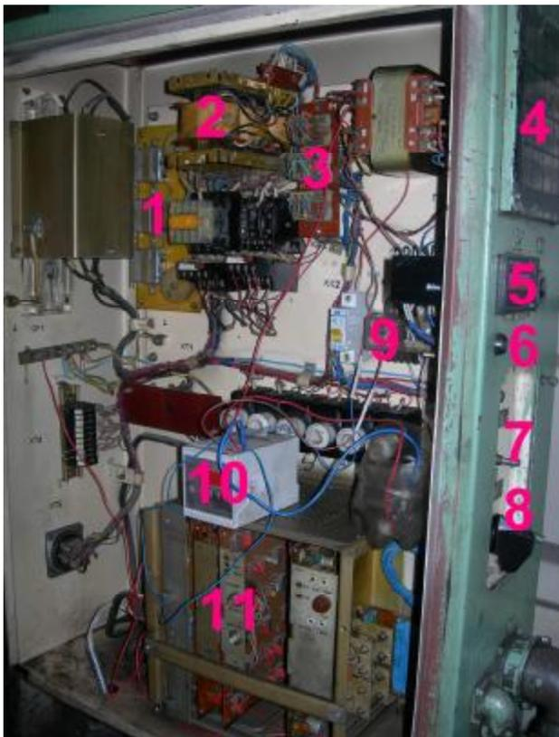
На фотографии выделены 11 позиций. После установки системы управления «Соло 3» данные компоненты не будут участвовать в управлении оборудованием и при желании могут быть демонтированы.
